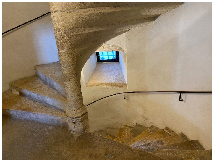
Légende : Vue des escaliers et des mains courantes menant au sous-sol et au 1 er étage.
